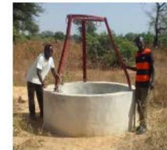
Le projet prévoyait la réalisation de 3 puits de 1.8 m de diamètre et 8.8 m de profondeur et la construction de 3 bassins de 2.5 m<sup>3</sup> de capacité
